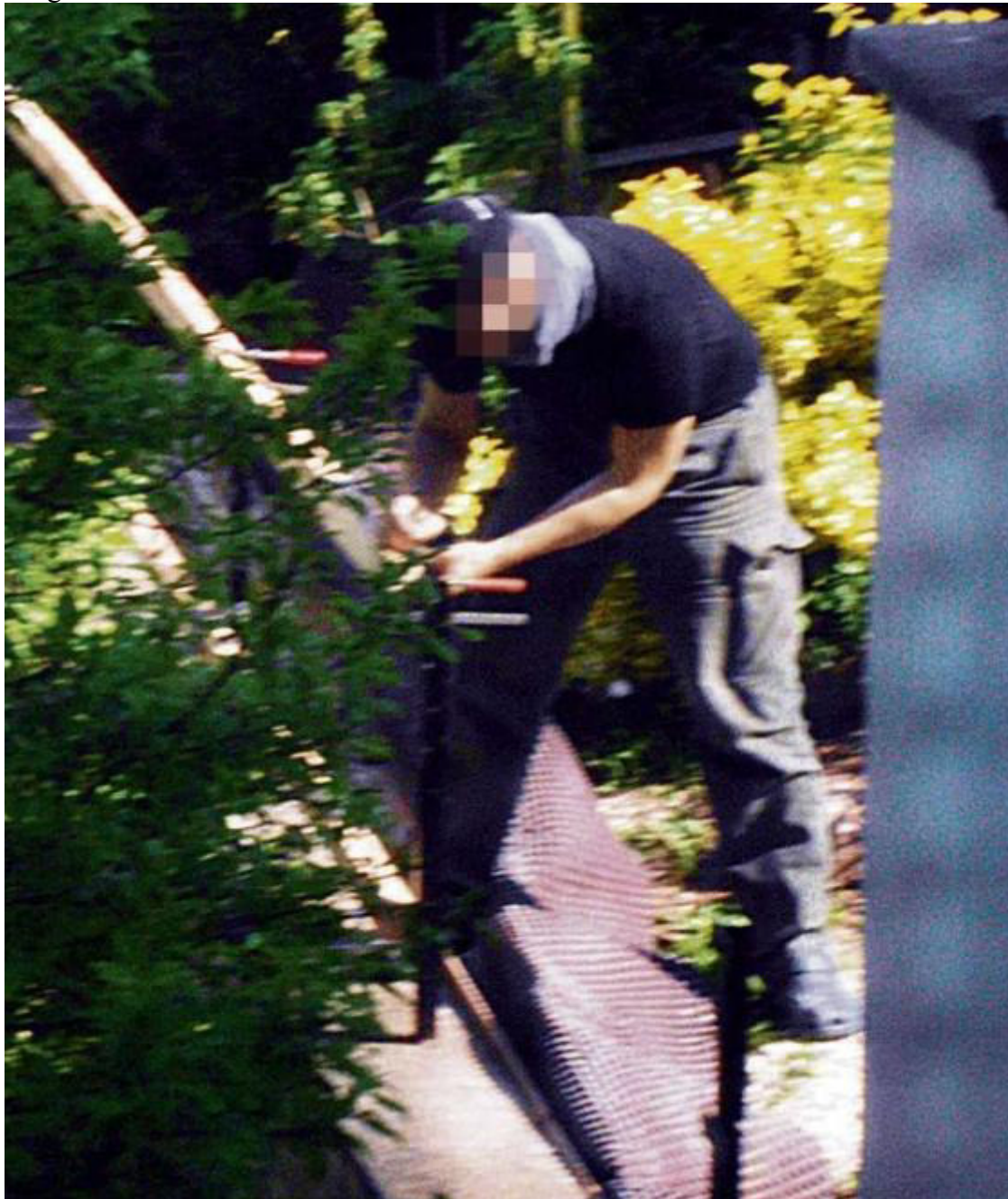
Nachbar Ralph F. werkelt an seiner Mauer Foto: Privat
